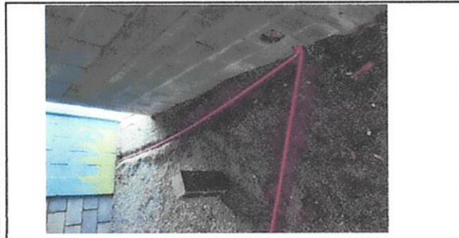
Foto 5: Instalación de energía eléctrica cocina
