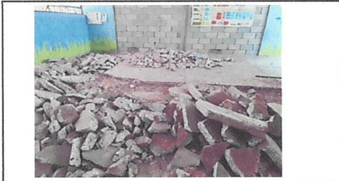
Foto 1: Demolición torta cemento
