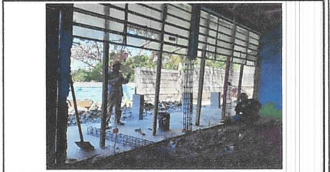
Foto 2: Demolición pared de adobe
